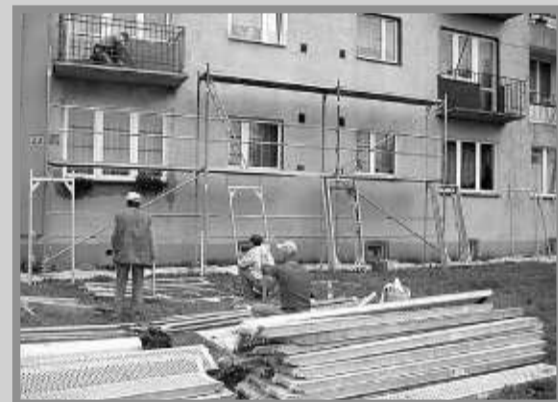
Ruszyły prace dociepleniowe bloku przy ul. Słowackiego.
