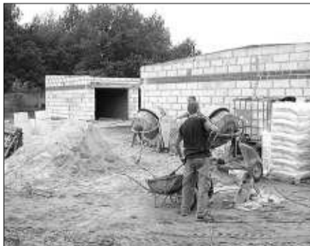
Przy ul. Śniadeckiego wybudowanych zostanie łącznie 100 garaży.
